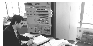
Figura 4 La serie IBM 360. El primer grupo de computadores construidos con circuitos integrados fue el de la serie 360 de IBM.
